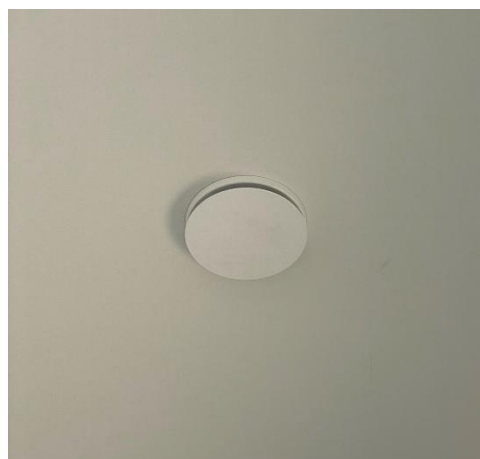
Plafondventiel voor ventilatie
