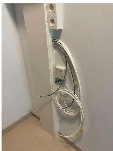
Aansluiting voor Proximus en Telenet
