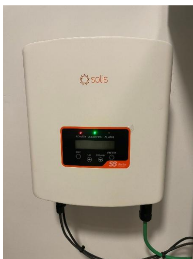
Omvormer zonnepanelen
