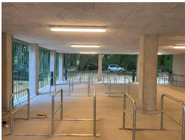
Overdekte en afgesloten fietsstalling met beugels.
