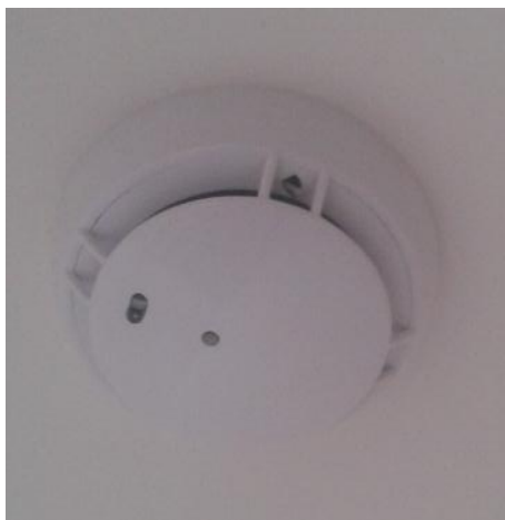
Multicriteria Rookmelder in de gemene delen
