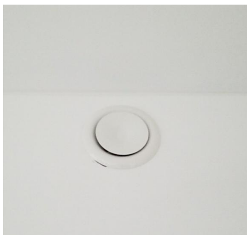
Muurventiel voor ventilatie
