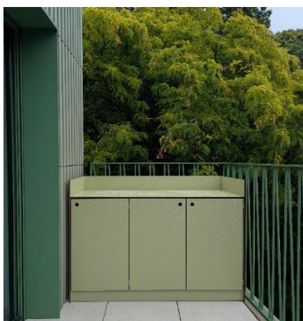
Terras - keramische tegels op tegeldragers met stalen borstwering en een bergkast.
