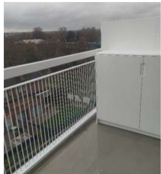
Uitkragende balkons met buitenkast
