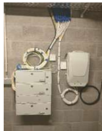
Fiber Data Proximus en Telenet in de algemene delen.
