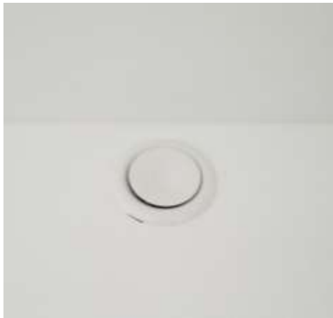
Ventiel voor ventilatie
