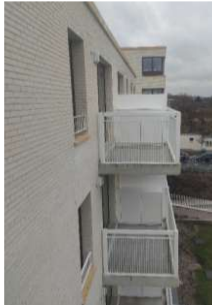
Terras - betonklinkers met metalen betonnen borstwering
