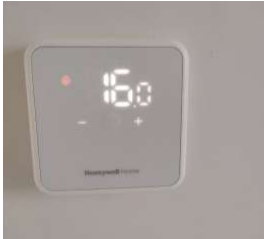
Kamerthermostaat met aflezen van de kamertemperatuur en regeling om warmer of kouder te vragen.
