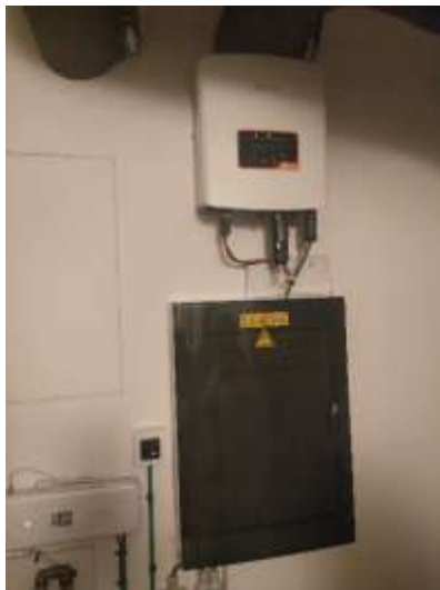
Omvormer zonnepanelen
