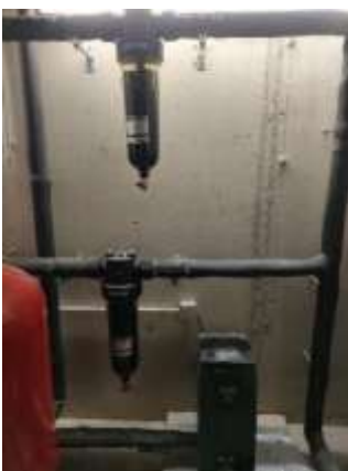
Filters voor regenwaterrecuperatie
