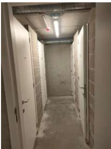
Een sas als toegang tot private kelderbergingen
