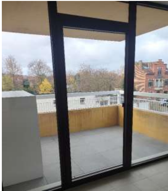
Terras - keramische tegels op tegeldragers met stalen borstwering
