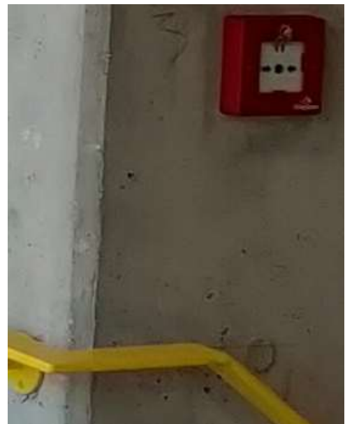
Multicriteria Rookmelder in de gemene delen Brandmeldingsknop
