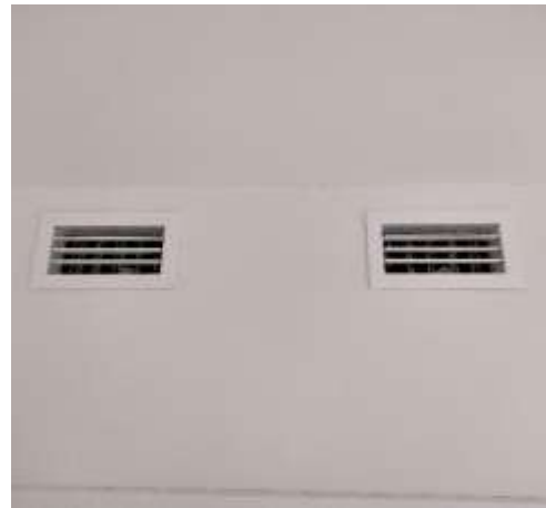
Inblaas ventielen voor efficiënte verluchting.
