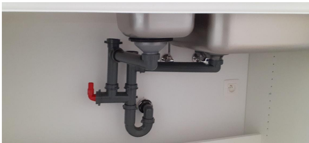
Aansluitingen vaatwasmachine
