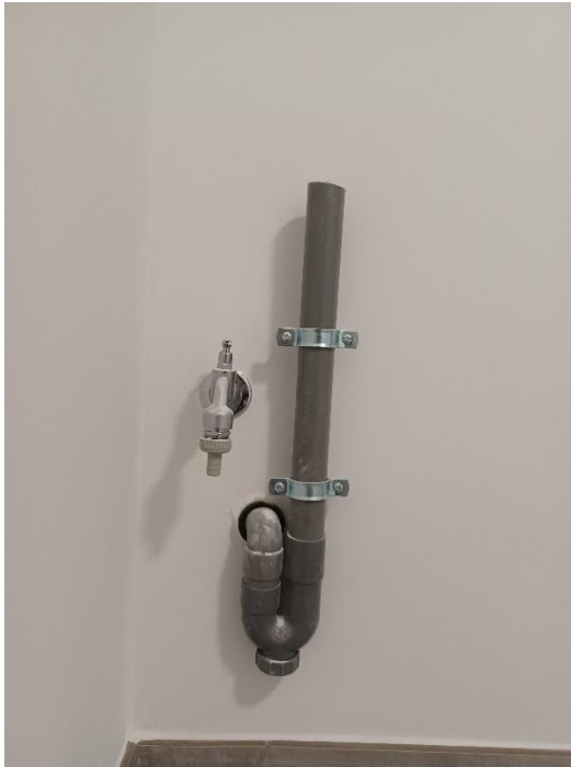
Aansluitpunt voor wasmachine en droogkast
