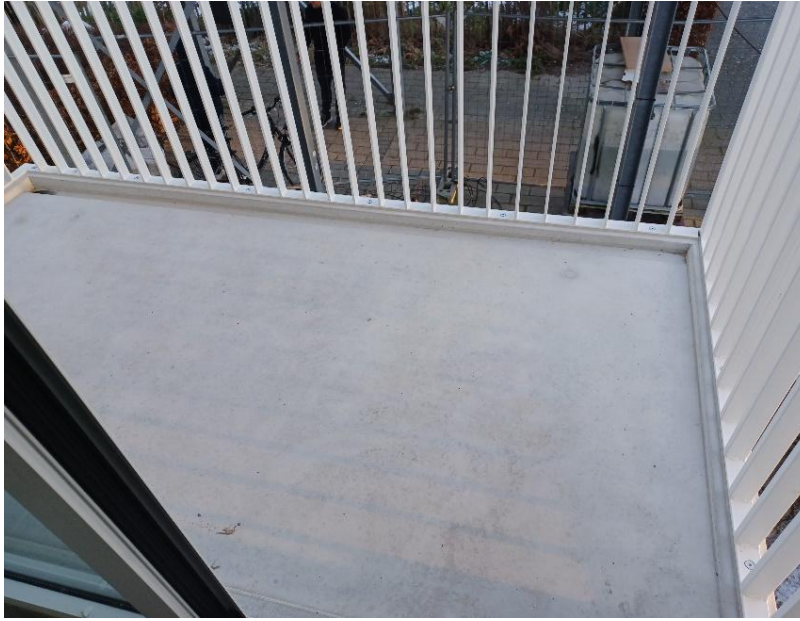
Terras of balkon met betonnen vloer en witgelakte stalen borstwering
