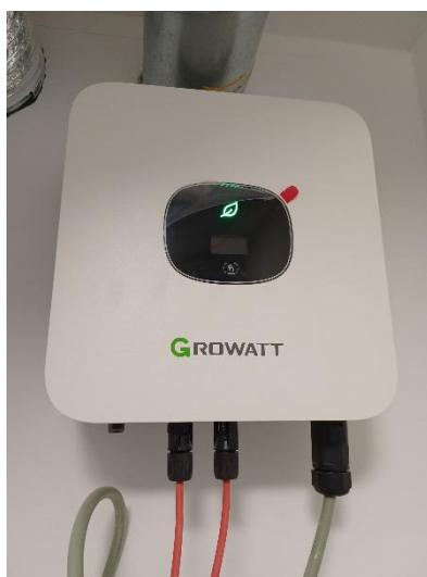
Omvormer zonnepanelen
