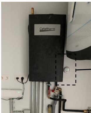
Warmtewisselaar met hoofdthermostaat
