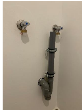
Aansluitpunt voor wasmachine en droogkast Kraantje voor drinkwater niet gebruiken.
