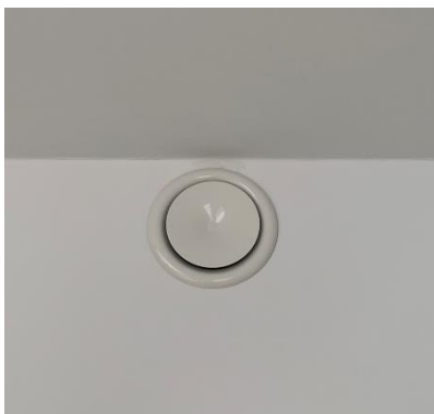
Ventiel voor toevoer van lucht
