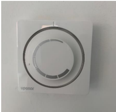
Kamerthermostaat wanneer er geen warmtevraag is (geen rood lichtje)
