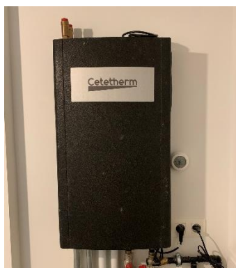
Warmtewisselaar in de berging
