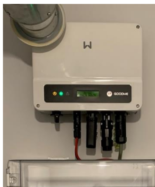
Omvormer zonnepanelen
