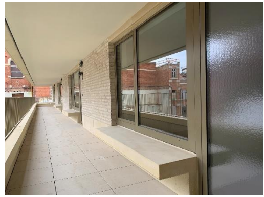
Galerij met toegang tot de meeste appartementen
