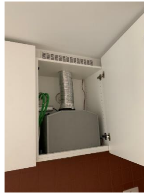
Uitblaasrooster boven de keukenkasten
