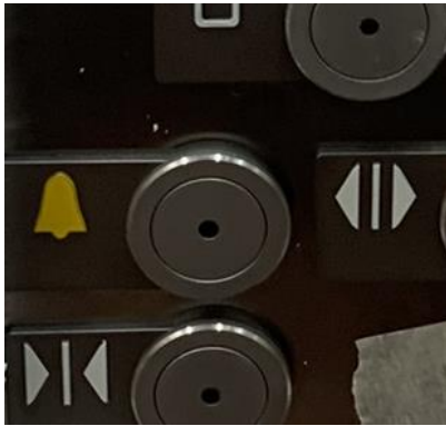
Alarmdrukknop met gele belletje
