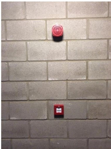
waarschuwingsdrukknop en alarmsirene in traphal
