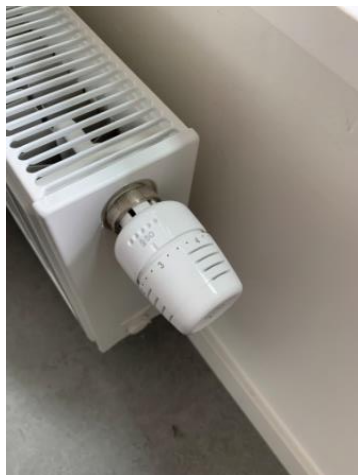
Thermostatische radiatorkraan
