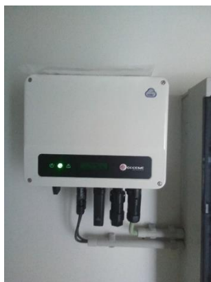
Omvormer zonnepanelen
