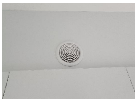
Uitblaasrooster boven de keukenkasten
