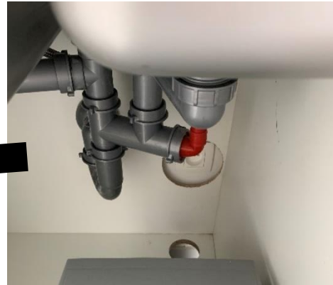
Aansluitingen afvoer en vaatwasmachine
