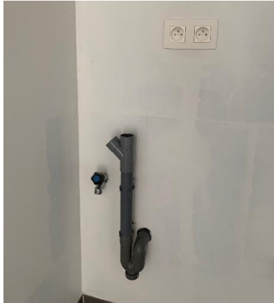
Aansluitpunt voor wasmachine en droogkast
