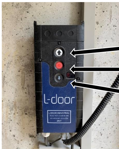
Bedieningspaneel garagepoort
