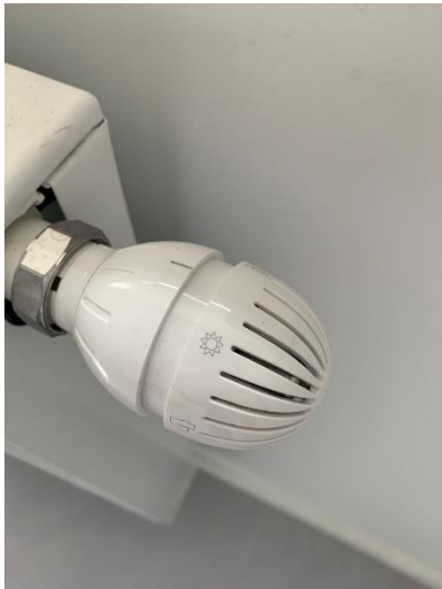
Thermostatische radiatorkraan
