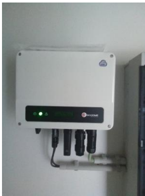
Omvormer zonnepanelen
