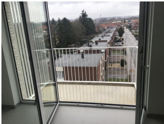
Terras met betonnen vloer en stalen borstwering
