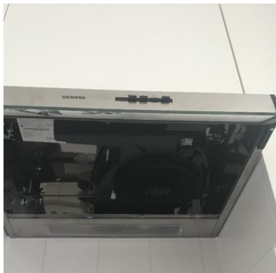
Dampkap, geopend (om filter te verwijderen)
