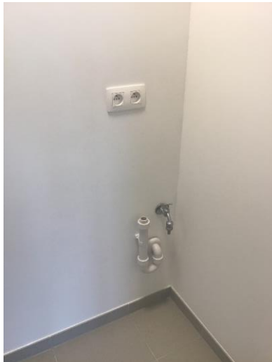
Aansluitpunt voor wasmachine en droogkast
