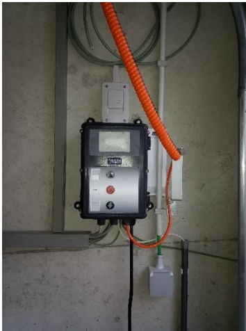
bedieningspaneel garagepoort
