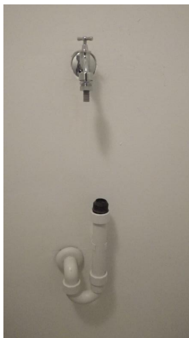
aansluiting wasmachine en droogkast
