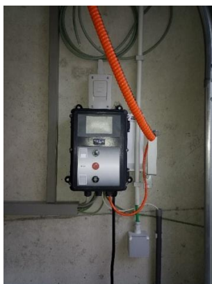
bedieningspaneel garagepoort
