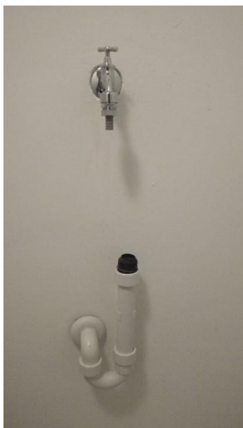
aansluiting wasmachine en droogkast
