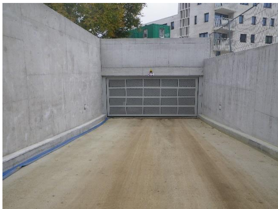
inrit naar de ondergrondse parking
