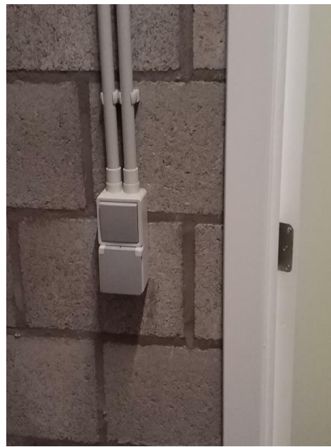
Individuele schakelaar en stopcontact
