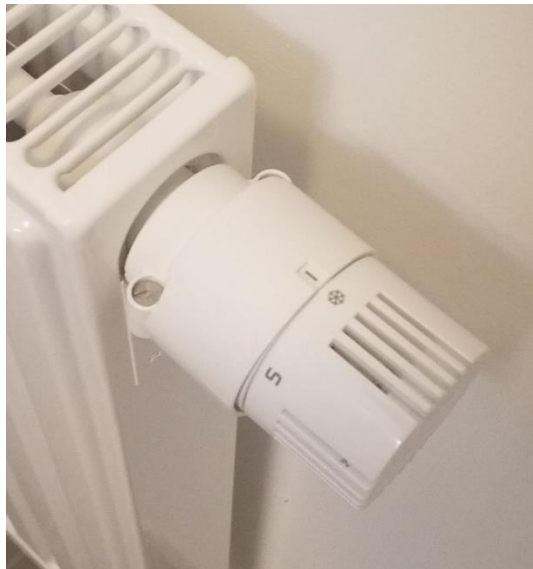
Thermostatische radiatorkraan
