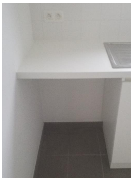
Voorbeeld uitsparing vaatwasmachine (verschillend per type appartement)
