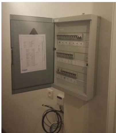
Zekeringsbord elektriciteit met schema
