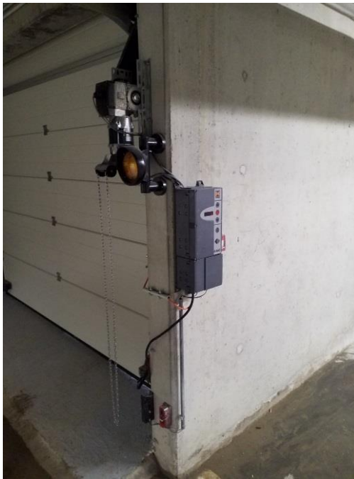
Bedieningspaneel garagepoort
