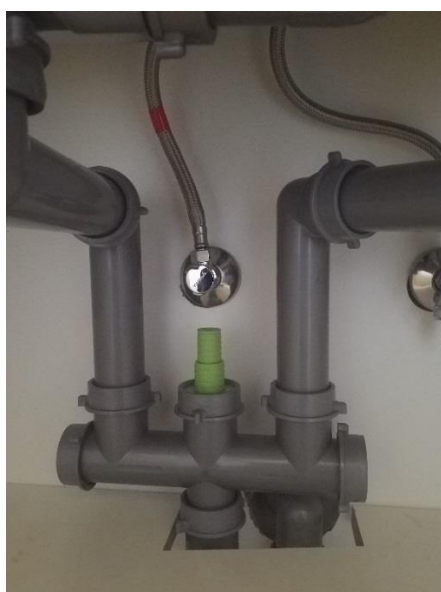
Aansluitingen vaatwasmachine
