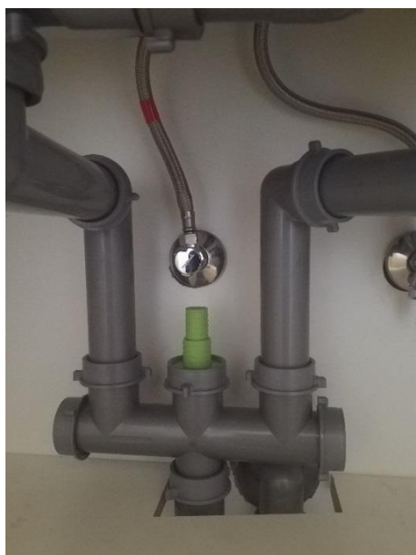
Aansluitingen vaatwasmachine
