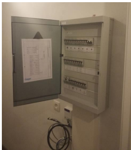
Zekeringsbord elektriciteit met schema
