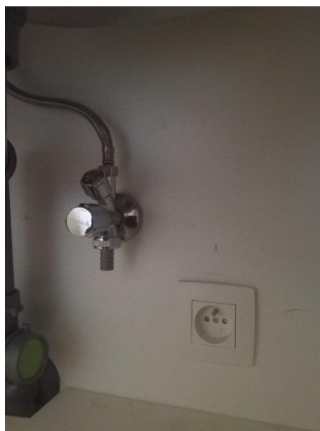
Aansluitingen vaatwasmachine
