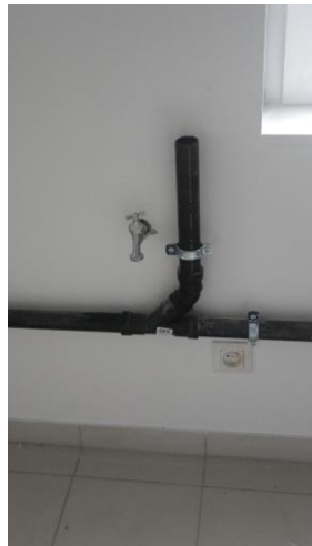
aansluitpunt wasmachine
