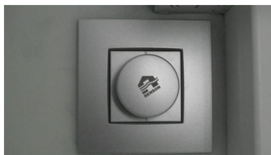
schakelaar ventilatie
