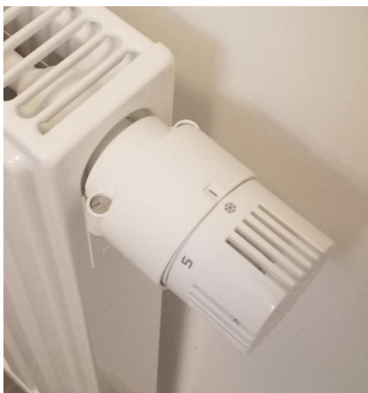
Thermostatische radiatorkraan
