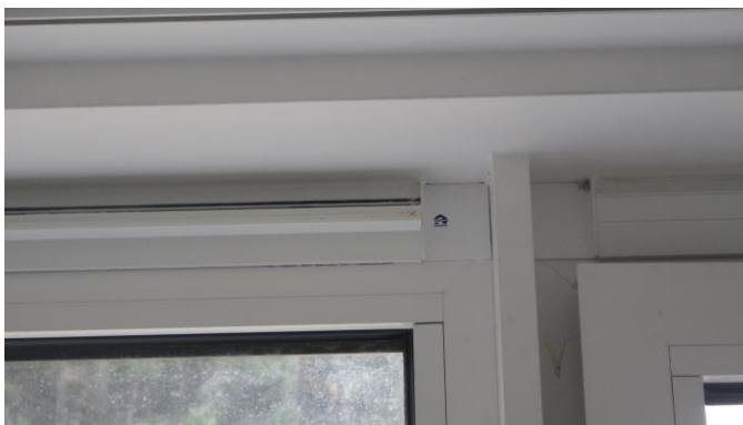
ventilatierooster in het raamprofiel
