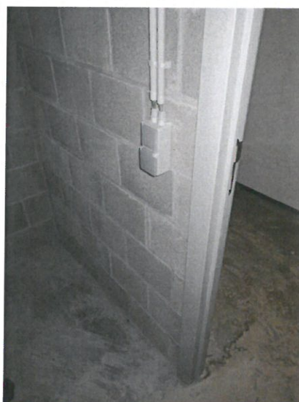
Individuele schakelaar en stopcontact
