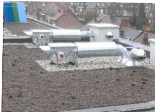
Bovendakse ventilatoren
