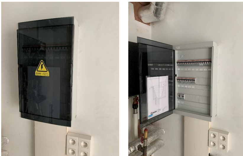
Elektrisch bord met schema
