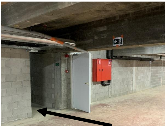
Toegang tot trap naar buiten via garage
