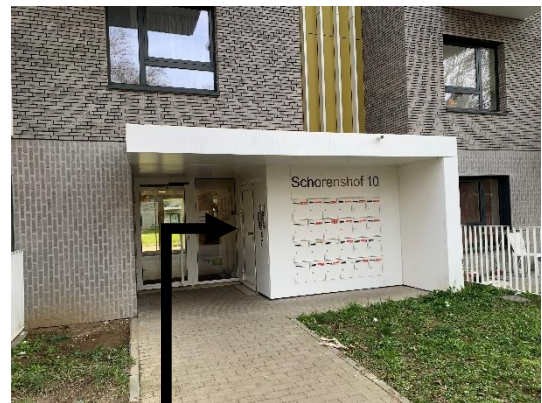
Toegang tot trap naar garage via buitendeur
