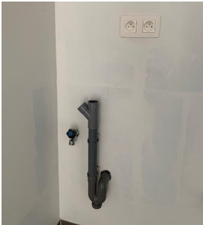
Aansluitpunt voor wasmachine en droogkast
