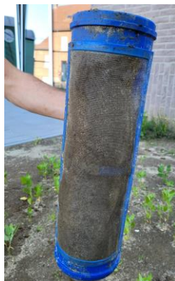
losmaken van de filter door te draaien en daarna te trekken
