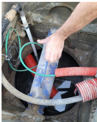
losmaken van de filter door te draaien en daarna te trekken
