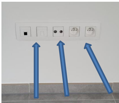
aansluiting internet, televisie en gewone stopcontacten
