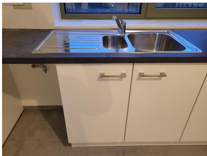
afwasbak met de nis voor de plaatsing van een vaatwasser
